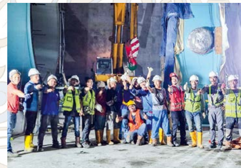
Installationsteam der Druckrohrleitungsabsperklappe
