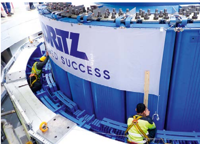
Installation des Generatorrotors von Maschinensatz A1
