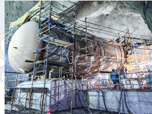
Der Drucktest für den Abzweiger von Asahan 3 wurde Anfang 2023 erfolgreich durchgeführt.
