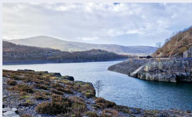
Mit einer Gesamtleistung von 1.728 MW ist Dinorwig eines der größten Pumpspeicherkraftwerke Europas
