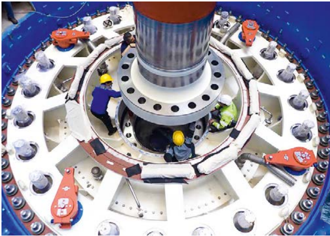
Installation der Turbinenwelle und des Leitapparats des Maschinensatzes A1
