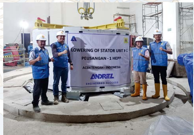
Installation des Stators von Maschinensatz 1 im WKW Peusangan 1
