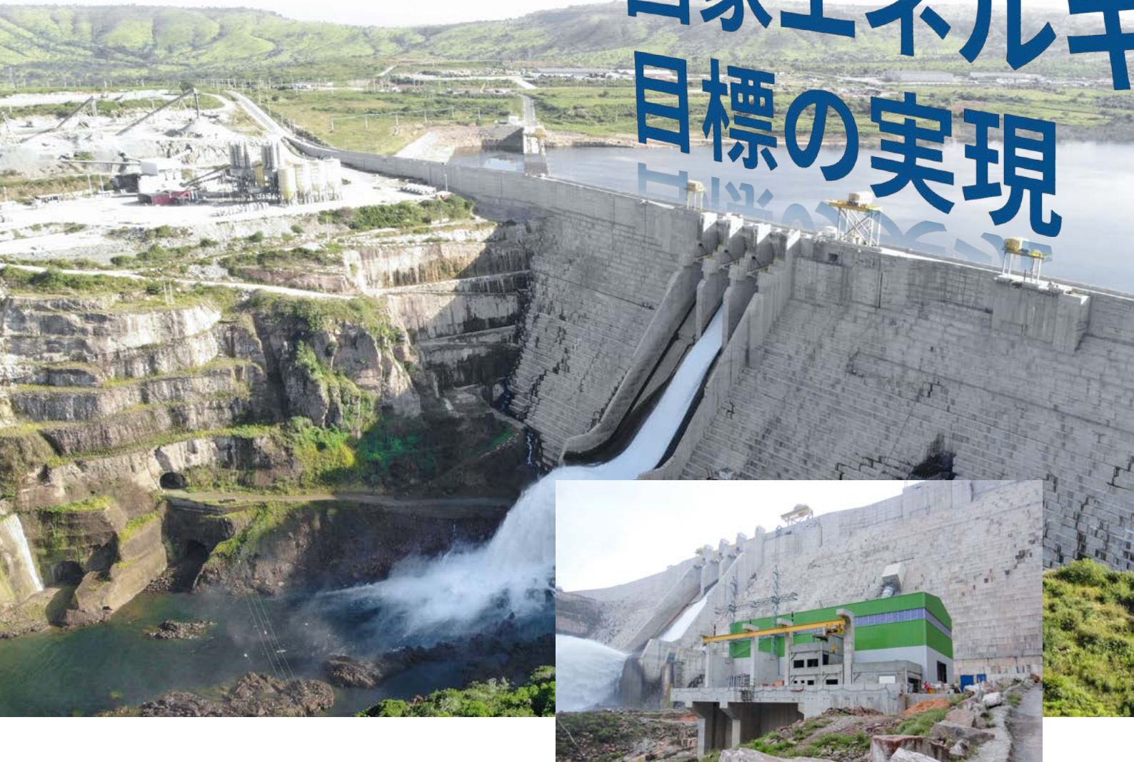
Laúca のすべてのユニットは、所有者とオペレータに満足いただけるスムーズな稼働をしており、全国送電網を安定させ、電力需要の動的な変化に対応しています。
