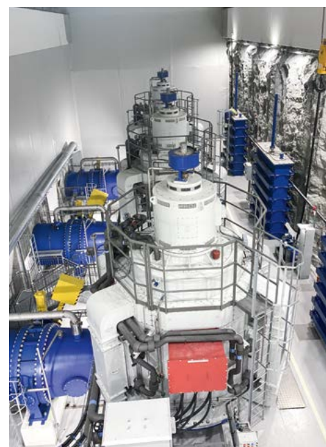
Tolga 発電所。この新しい流れ込み式発電所には、同じ15MWのコンパクトフランシス水車が3台装備されています。
