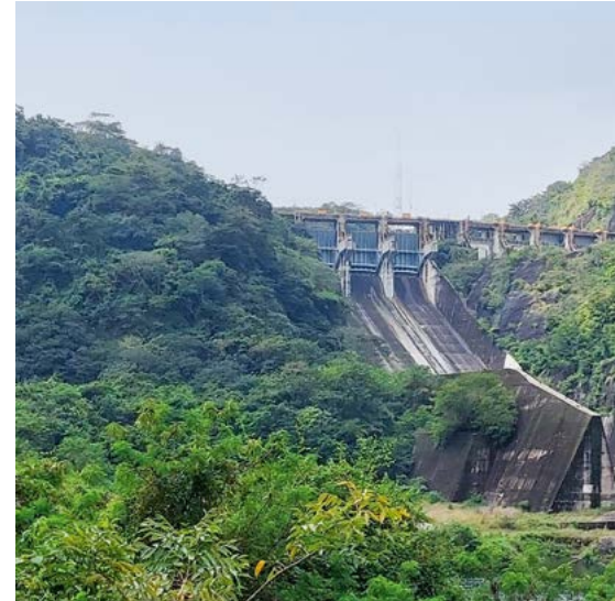
マルパソダムと放水路
