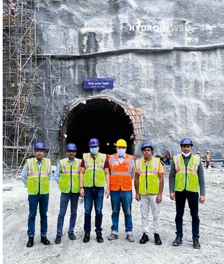
工事はすでに進行中です。このプロジェクトの建設期間は5年と見積もられ、完成は2026年12月に予定されています。
