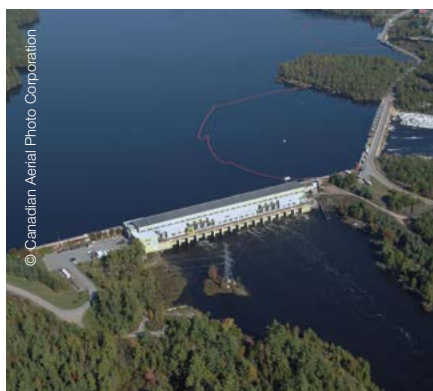
Vista aérea da Estação Geradora de Chenaux
