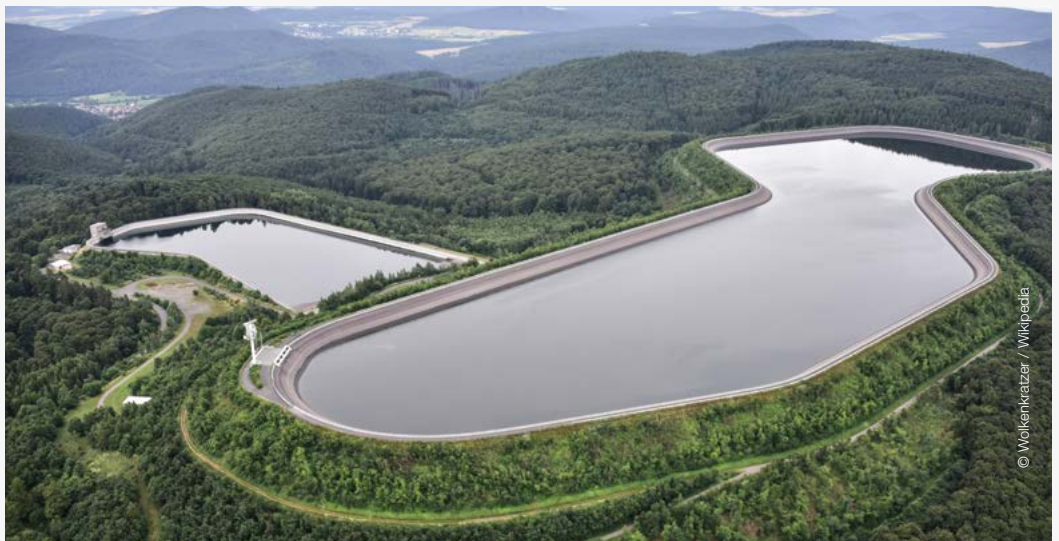
A Uniper Kraftwerke GmbH/Alemanha instalou os sistemas na UHR Waldeck 1 (uma turbina-bomba de 70 MW) e na UHR Waldeck 2 (duas unidades ternárias, cada uma com 240 MW) em 2017
