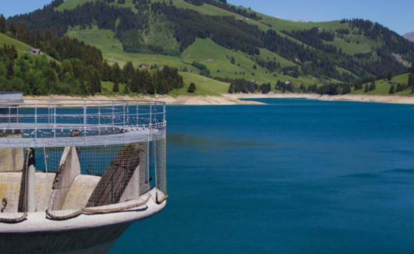
Vista do reservatório Lac de l'Hongrin
