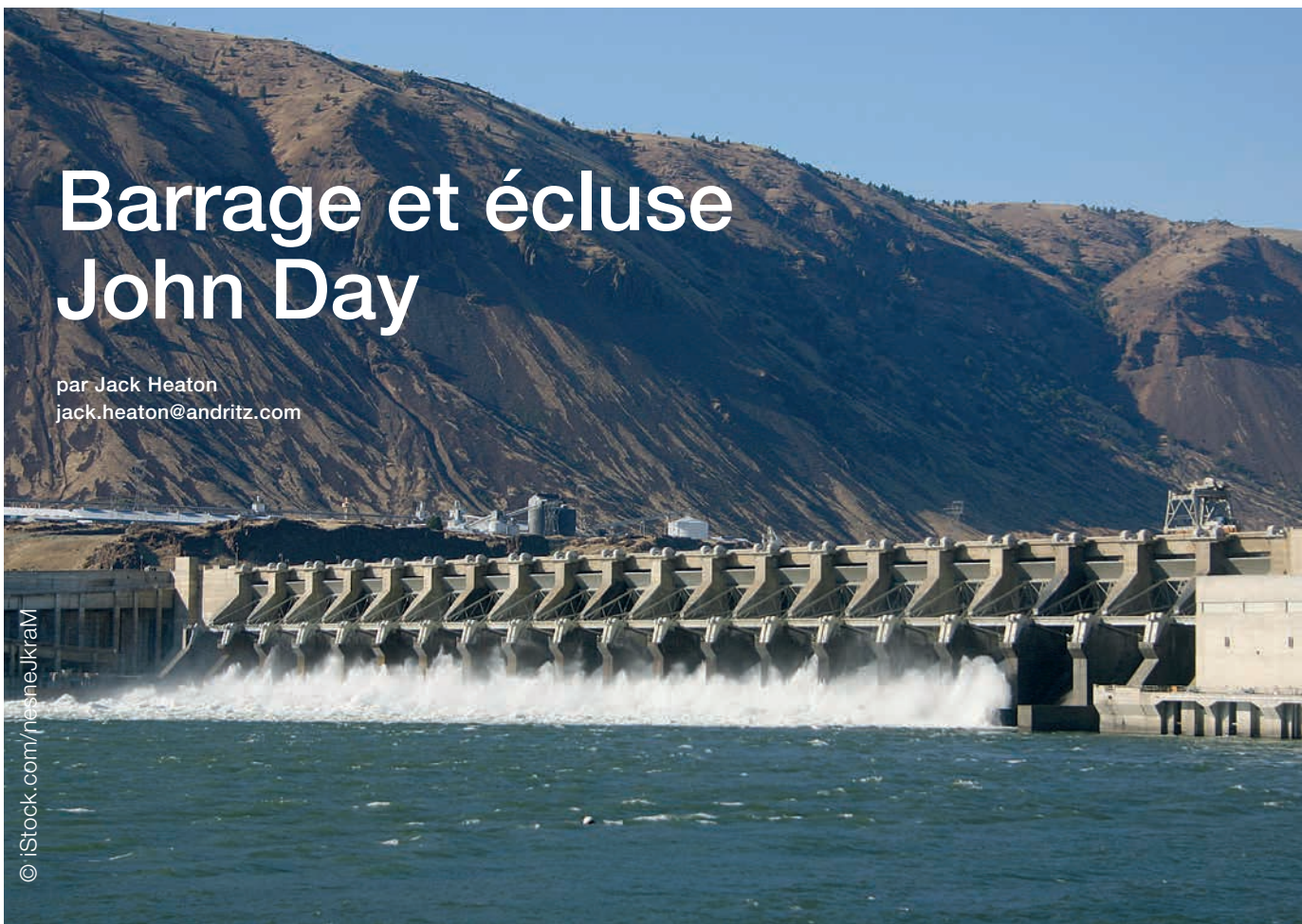
Vue du barrage
