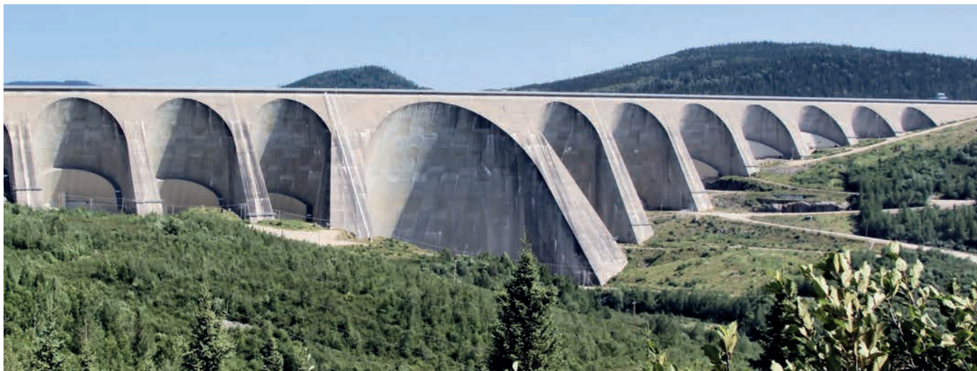
Vue du barrage
