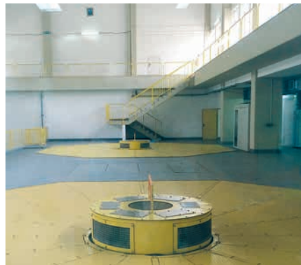
La salle des machines avant la réhabilitation
