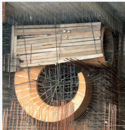
Préparation du bétonnage sur site
