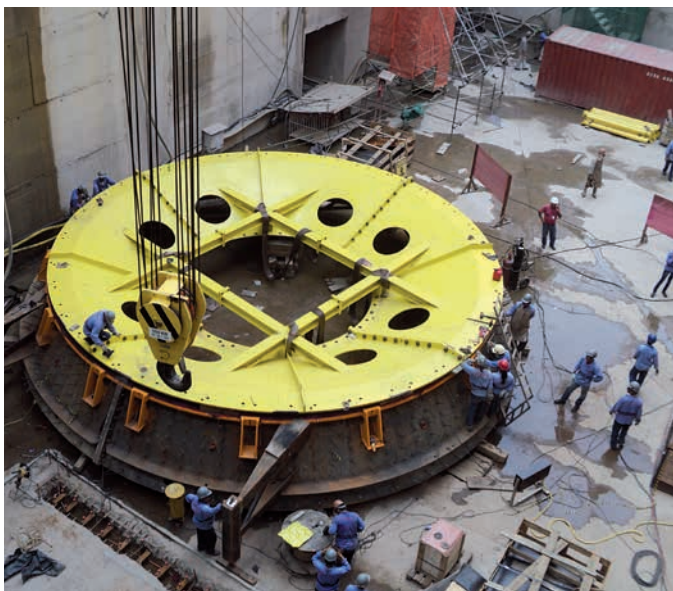
Les travaux d'installation
